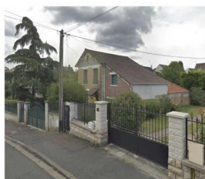
Brique de parement présent sur la façade du 13 rue de Chanteloup
