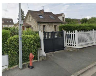
Parement de pierre présent sur la façade du 19 rue de Chanteloup
