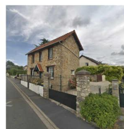
Parement de pierre présent sur la façade du 24 rue de Chanteloup
